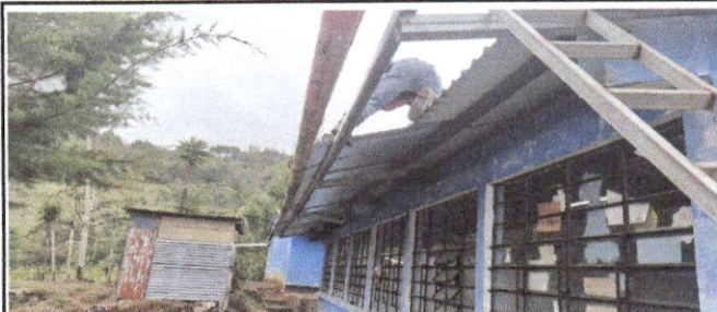
Foto 1: Canal y techo de pestaña que no servía para recolectar agua de lluvia, fue extraído y reemplazado por nuevas láminas y canal de metal.
