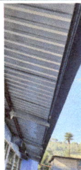
Foto 2: Techo de pestaña y canal de metal instalado por nuevas estructuras.
