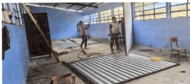
Foto 3: Colocación de divisiones de metal en las aulas y piso cerámico.
